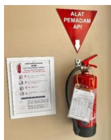
Gambar 3 Pemasangan APAR
