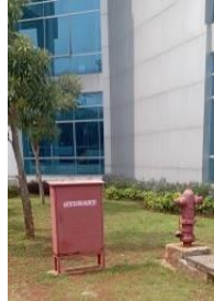
Gambar 9. Hidran Halaman
